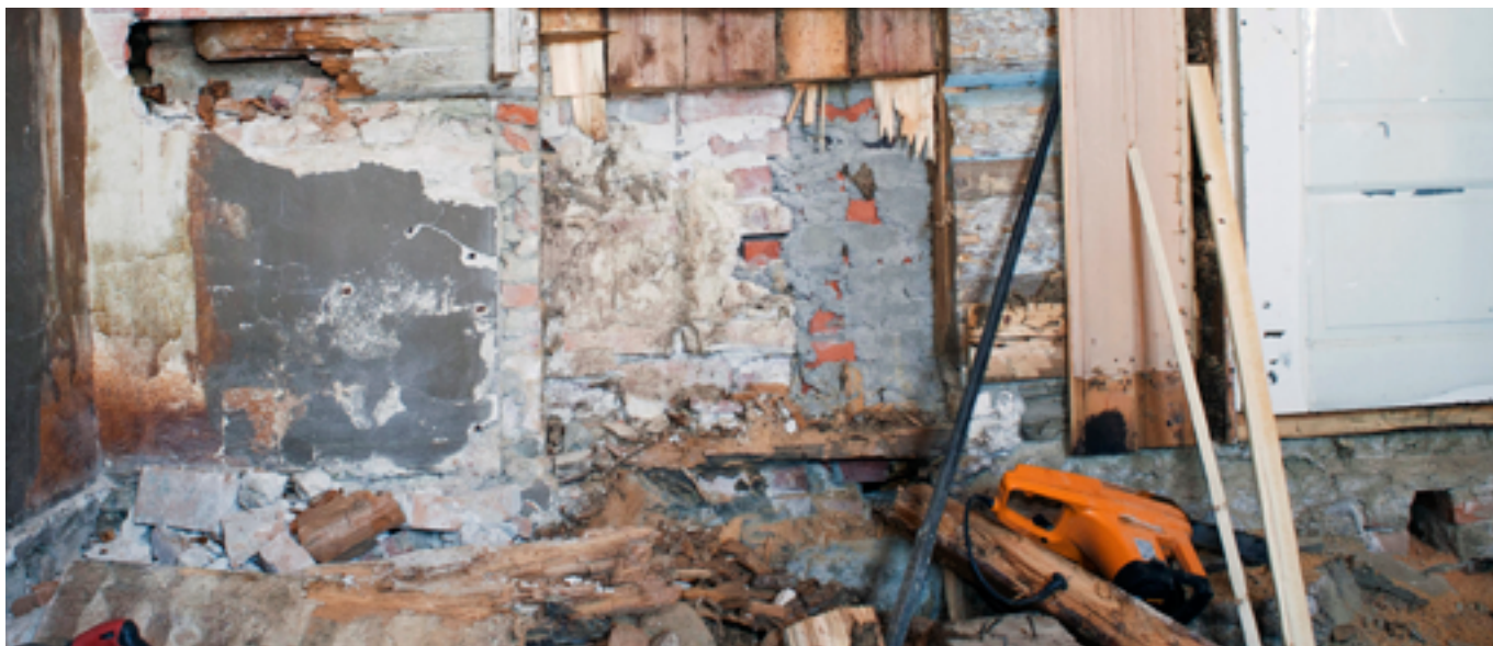
VEGG MOT NORD MELLOM BRANNMUR OG DØR
