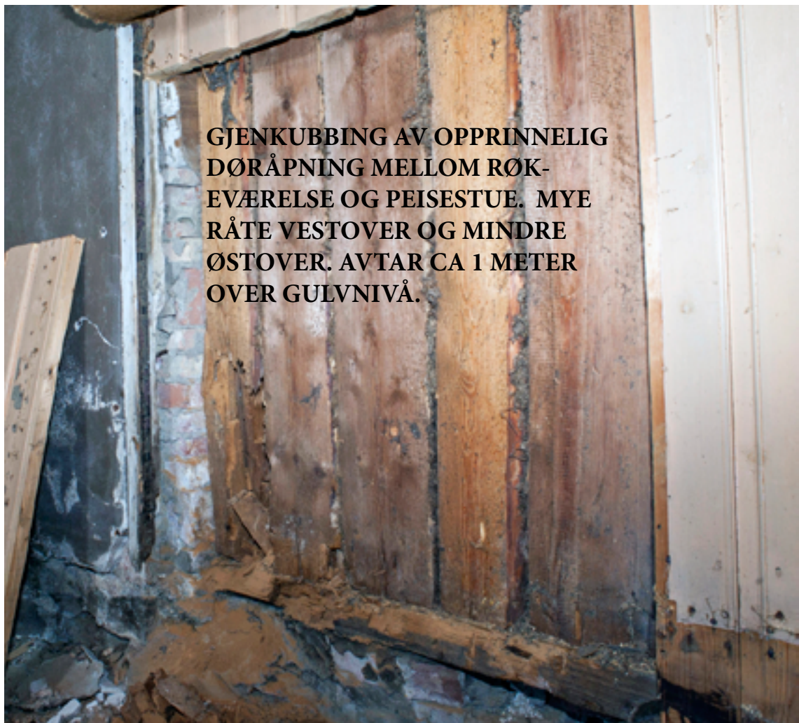
VEGG MOT NORD GJENKUBBING
