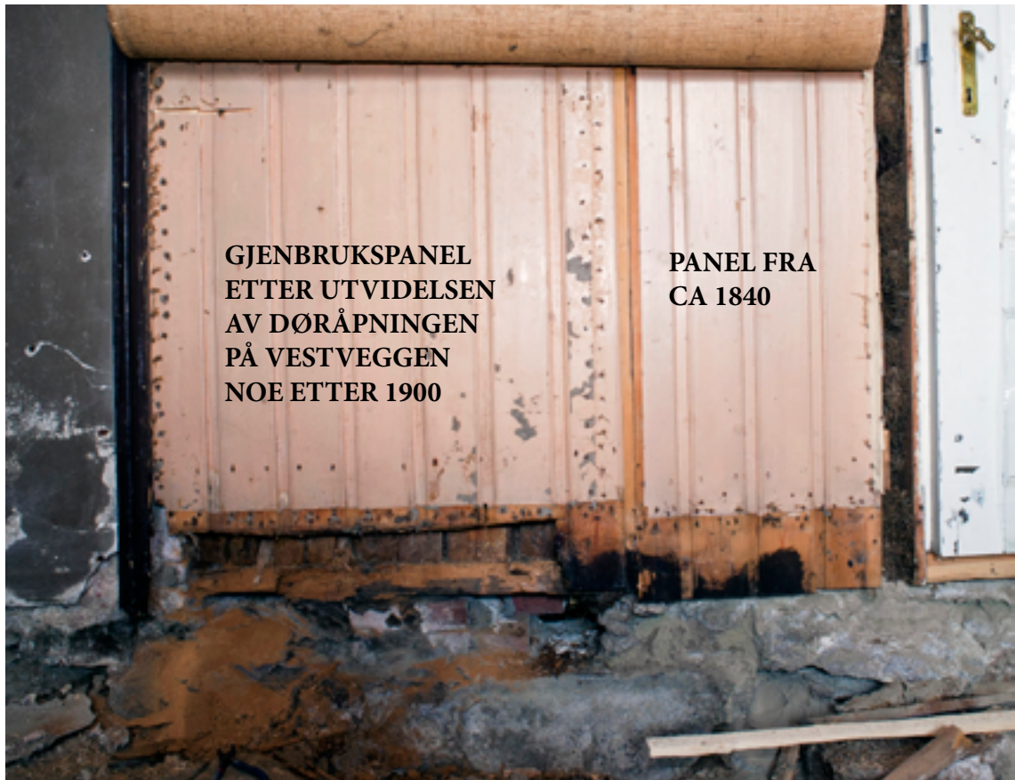
VEGG MOT NORD FØR ÅPNING MOT GJENKUBBING
