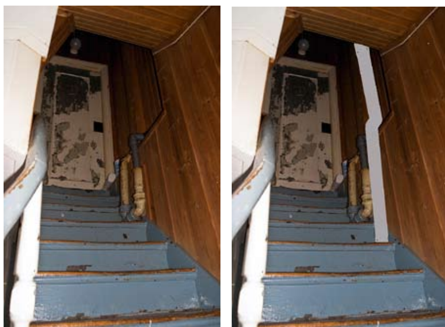
Fotoillustrasjoner av kanalgjennomføring i kjøkken. Grå markering viser trasé for kanal.
