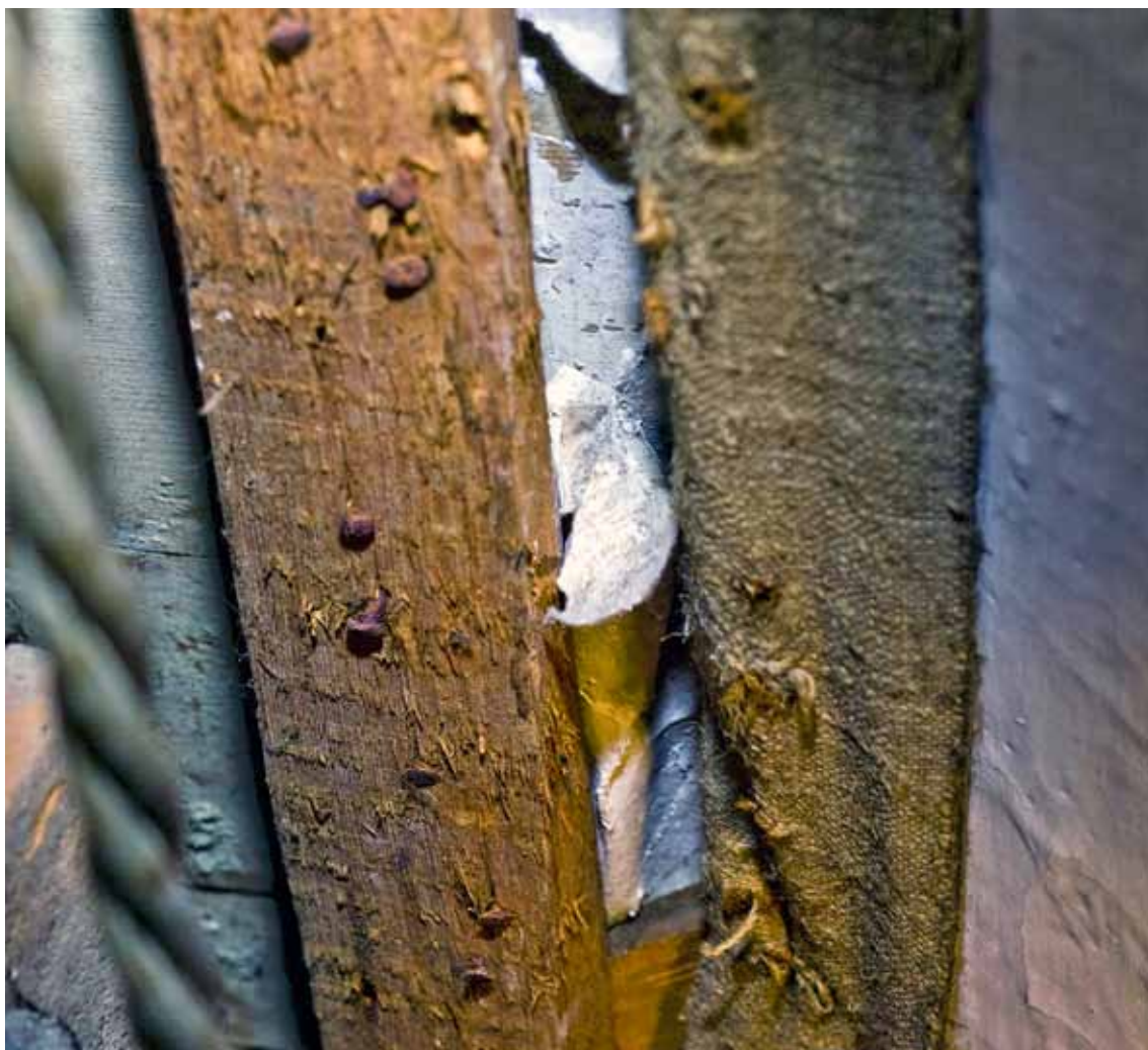
Himlingsbord skimtes til venstre og papir til høyre for lekten. Lerretet er løsnet og trukket tilbake.
