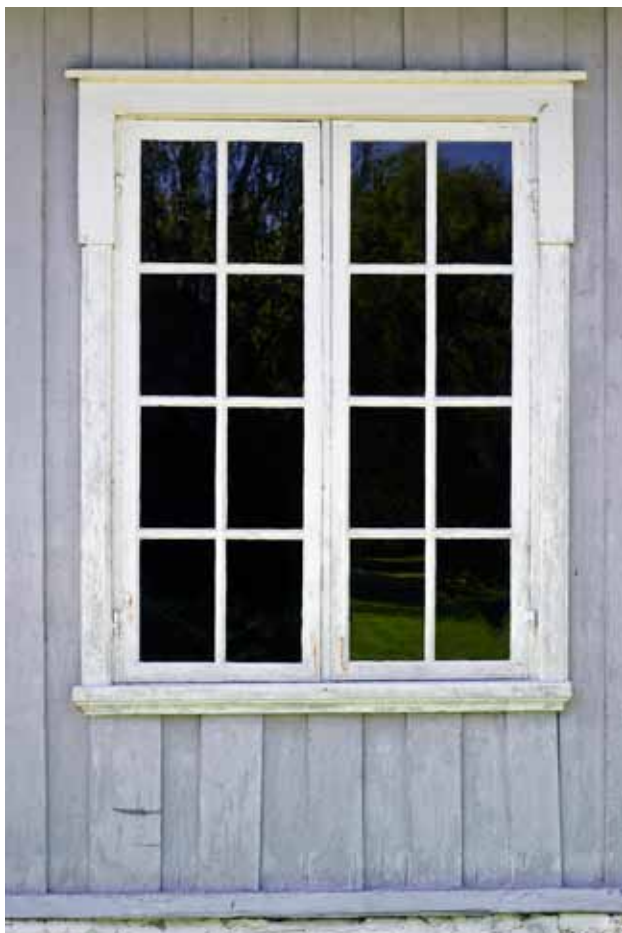
Utvendige vindusdetaljer. Legg merke til at hjørnejernene er fellet inn i rammen.
