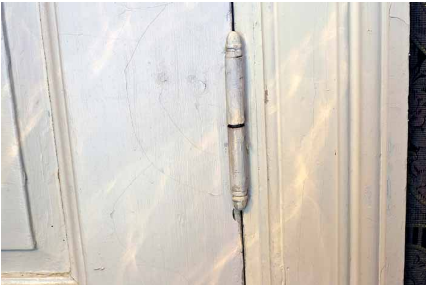
Under: Dørhengsle av tidlig 1900-talls type. Tilsvarende hengsler benyttet på den firefløyede døren mot vest.
