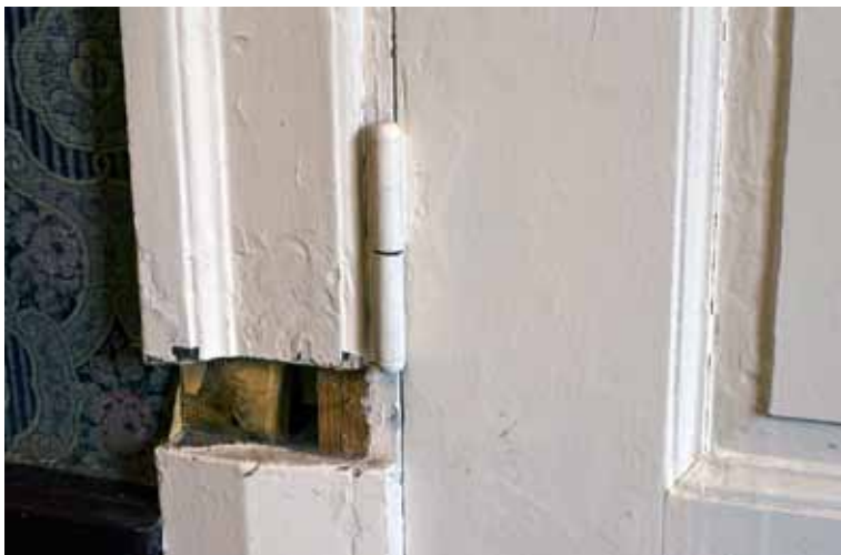
Dørhengsle på dør mot nord. 1940-50 talls type. Antagelig påsatt da dørbladet ble rotert for endret slagretning.
