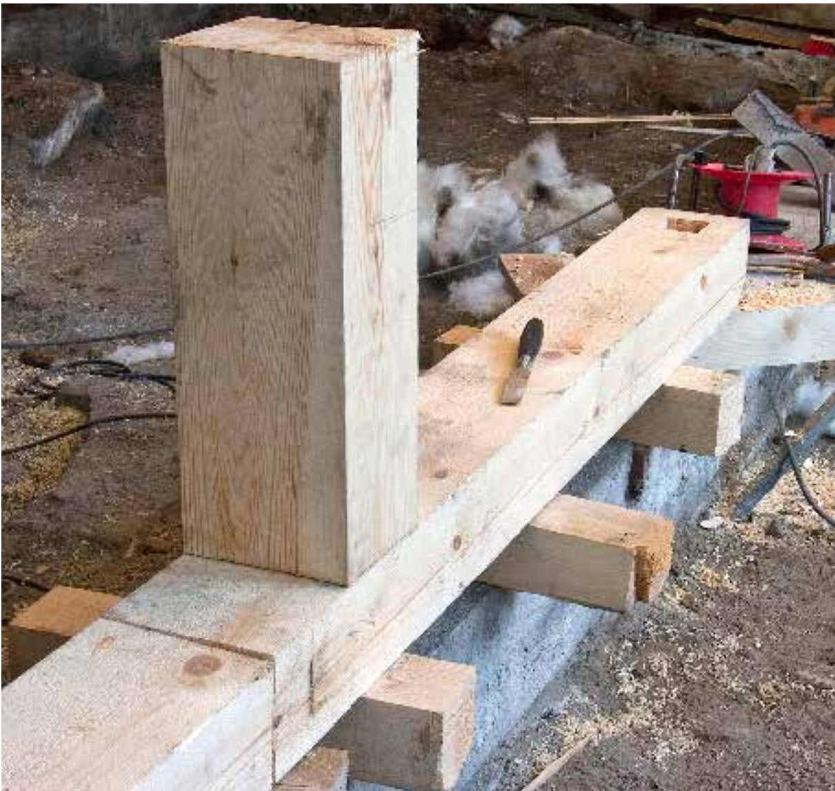
Sinkforbindelse og prøving av tapping. Tilpasningen var svært tett og god.
