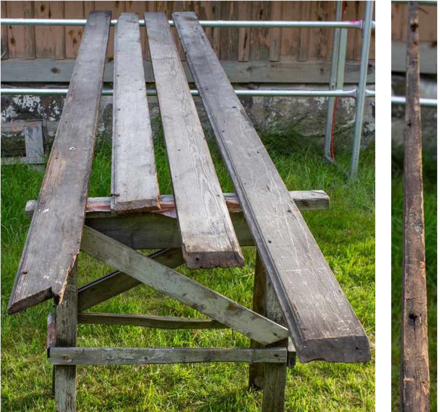
Over: De fire bordene samlet. Til høyre: Toppsiden av vindski med spikerhull etter dekkbord og råteskader. Under: Enden på en vindski. Formet etter overgangen mot gradrenne og takstein?
