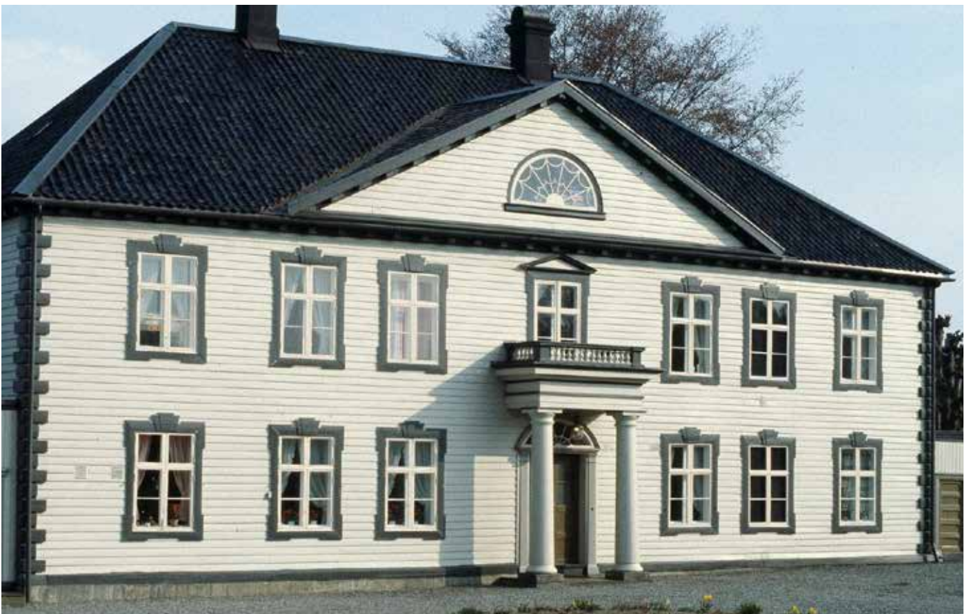
Strømsbu, Arendal. Utforming noe etter 1804. Gavlen gjentar hovedgesimsens utforming. Foto Aust-Agder fotodugnad, webside.
