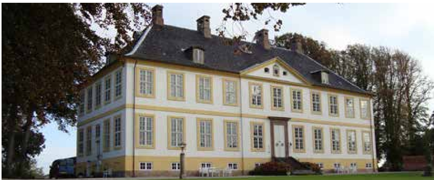
Fredrikslave (Hagenskov), Fyn. Gjenreist 1775 etter brann. Midtrisalitt, men ellers gavl som hovedgesims. Foto: Dansk senter for herregårdsforskning.
