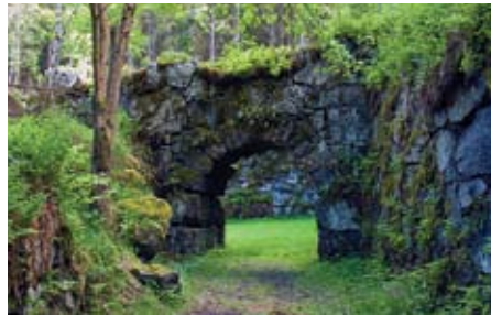
Inngangen til den store kullkjelleren
