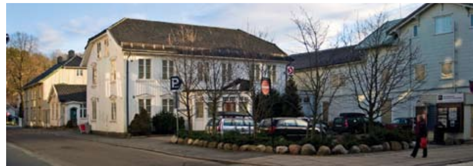
Det politiske flertallet i Sandefjord vil erstatte dette bevaringsverdige bygningsmiljøet fra 1850-årene med en betongkloss. Konflikten har fått nasjonal rekkevidde.
